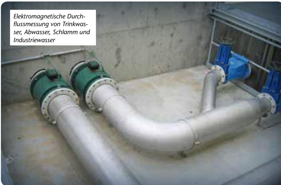
Elektromagnetische Durchflussmessung von Trinkwasser, Abwasser, Schlamm und Industrierwasser
